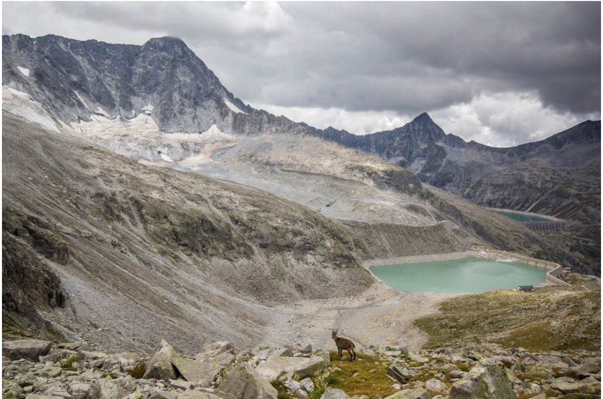
FIGURA 55. SISTEMA DELLE DIGHE DELL'AVIO
